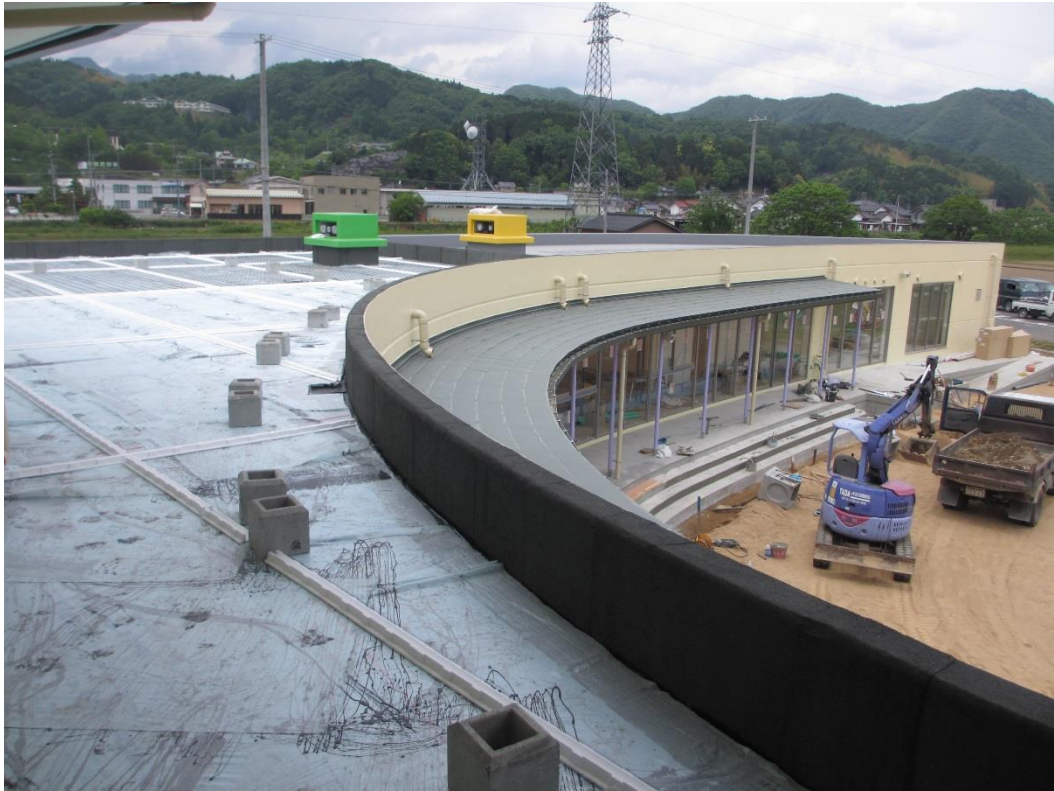
屋上の仕上げ工事の様子です。園庭と園舎との接合部分の工事も行っています。
